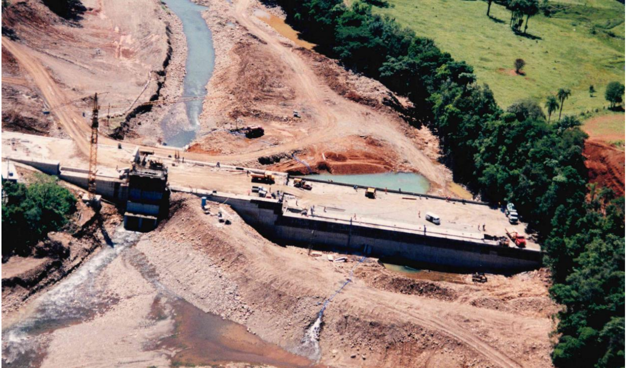
Figura 4: Barramento principal - estágio inicial da obra.
