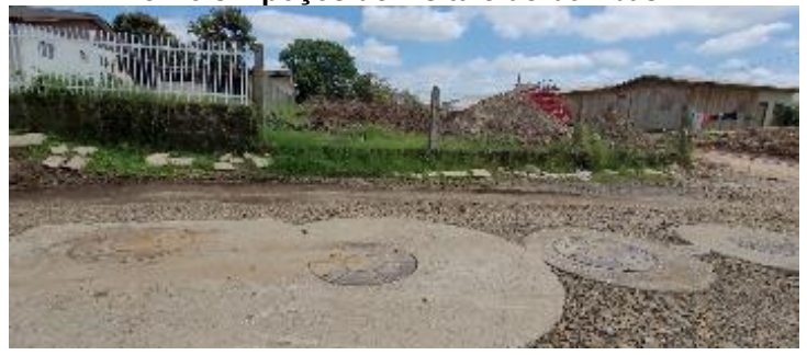
Figura 100: EEE-15 - Bairro Santa Isabel - Rua Cinquenta e Dois – poços de visita e de bombas.
