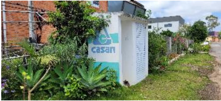
Figura 97: EEE-15 - Bairro Santa Isabel - Rua Cinquenta e Dois – visão geral.
