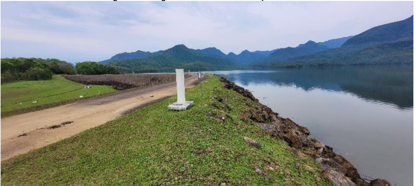
Figura 9: Barragem do Rio São Bento - Dique Secundário.
