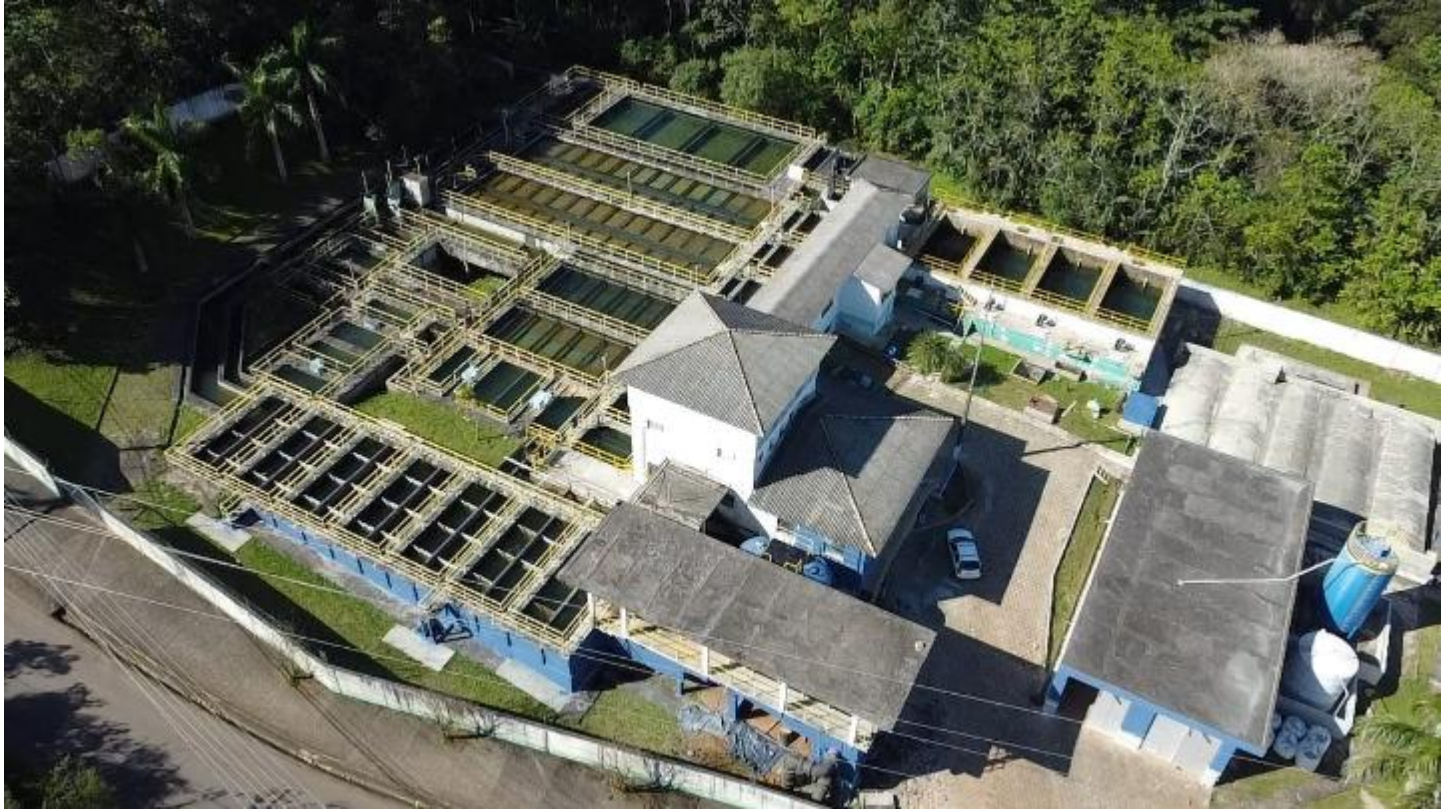
Figura 15: ETA São Defende - Vista aérea das unidades de tratamento.
