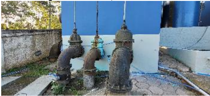
Figura 16: ETA São Defende - Chegada das adutoras de água bruta de 350, 400 e 600 mm.
