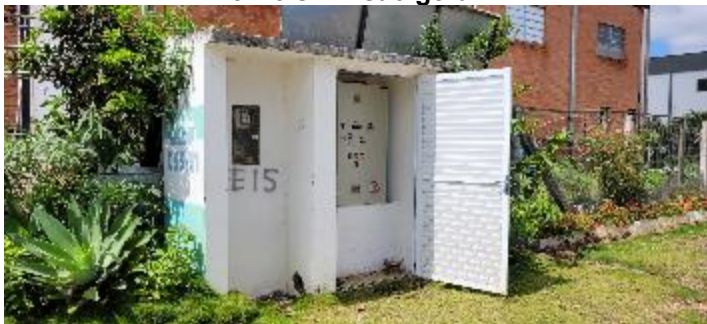
Figura 99: EEE-15 - Bairro Santa Isabel - Rua Cinquenta e Dois – visão geral.
