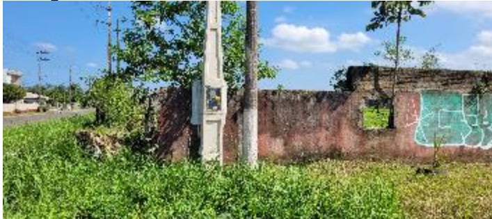
Figura 73: Macromedidor da Rua Lucas Peruchi.
