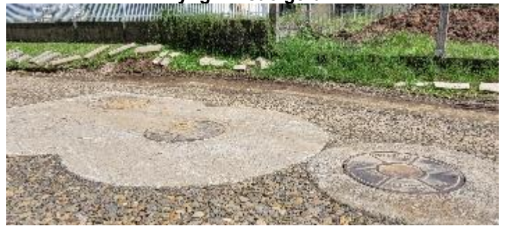
Figura 104: EEE14 Bairro Santa Ana – Rua Gabriel Eyng – visão geral.
