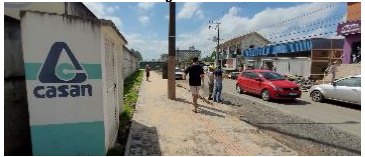
Figura 115: EEE10 – B Centro – Av. 25 de Julho – visão geral.
