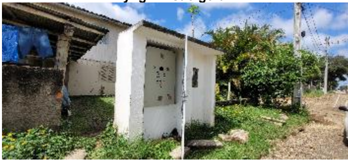
Figura 103: EEE14 Bairro Santa Ana – Rua Gabriel Eyng – visão geral.
