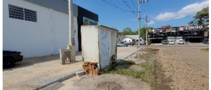
Figura 119: EEE07 Bairro Santa Clara - visão geral.
