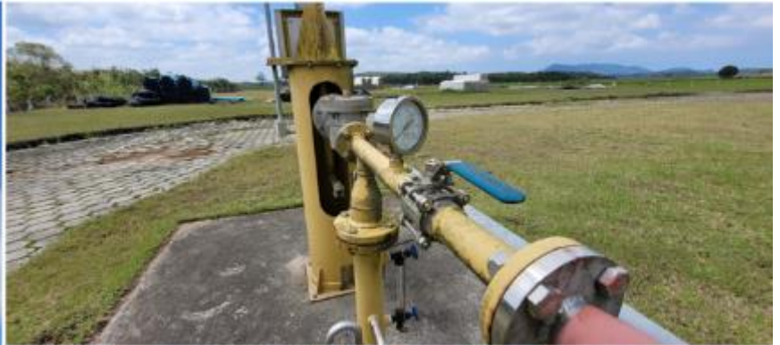
Figura 145: ETE Forquilha – Queimador de gás.
