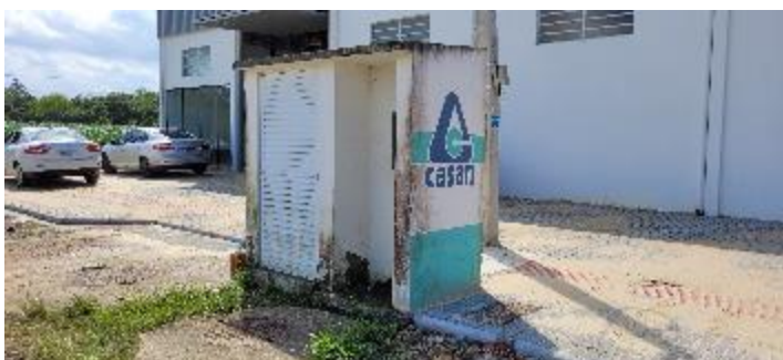
Figura 116: EEE07 Bairro Santa Clara – visão geral.
