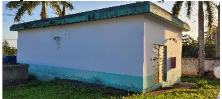
Figura 51: ETA São Defende - Subestação elétrica.
