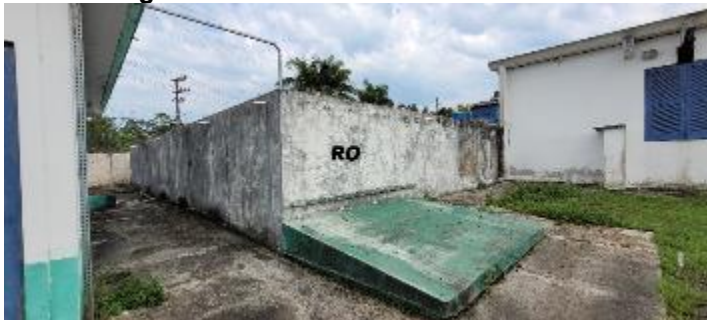
Figura 59: Reservatório R0 - 2.000 m³.
