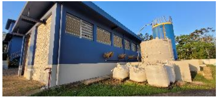
Figura 39: ETA São Defende - Casa de dosagem de cloro – visão externa.
