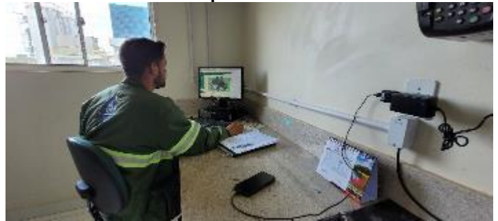
Figura 163: ETE Forquilha – Laboratório – sistema supervisorio.
