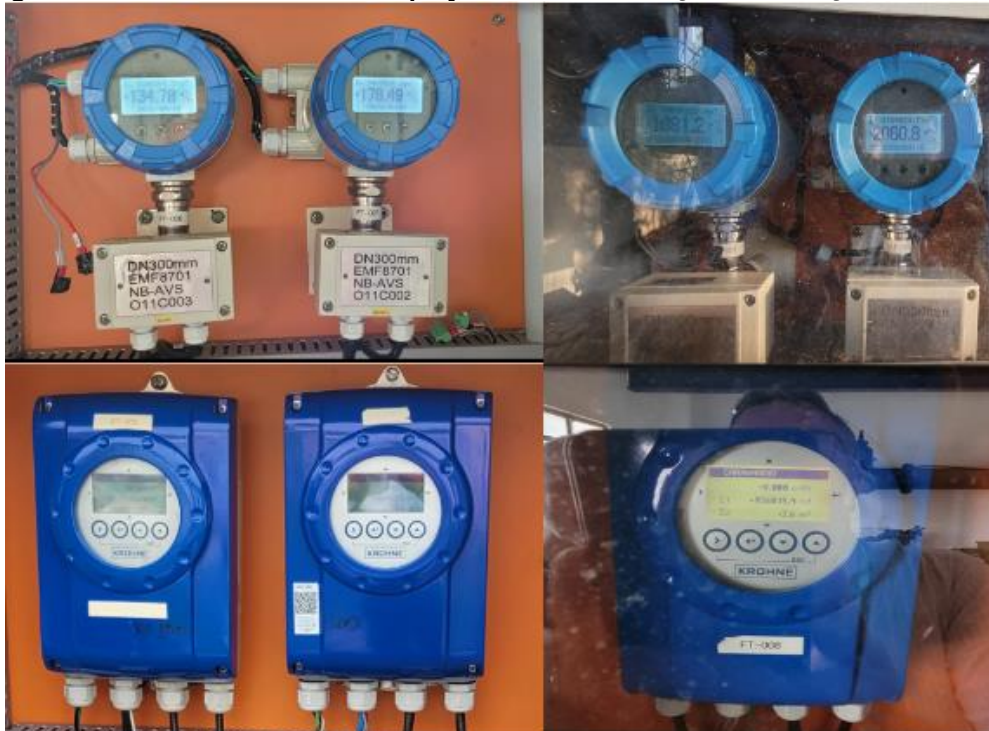
Figura 64: ETA São Defende - Displays da instrumentação de medição de vazões.
