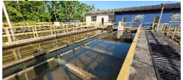
Figura 29: ETA São Defende – Decantadores.
