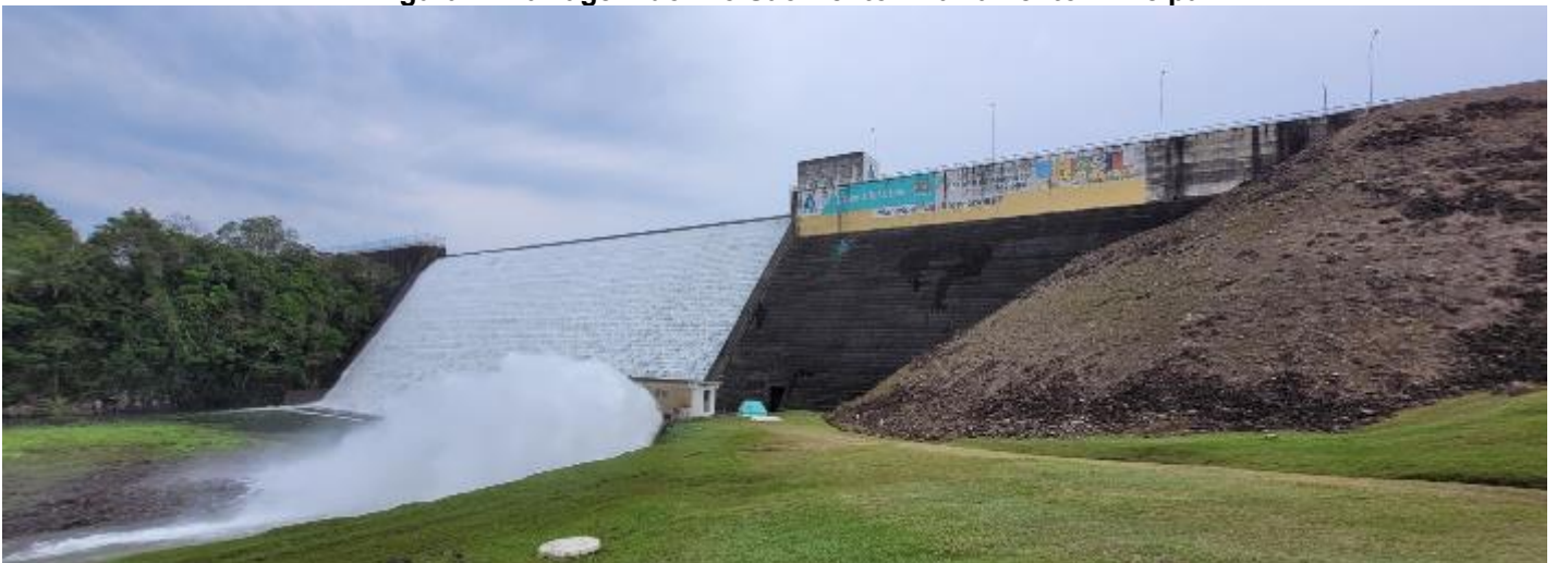
Figura 7: Barragem do Rio São Bento - Barramento Principal.
