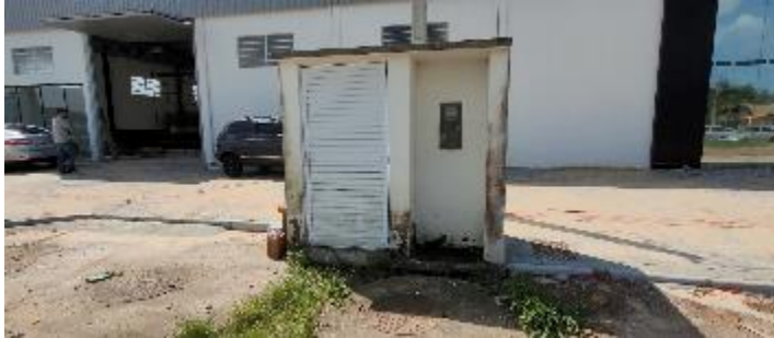
Figura 118: EEE07 Bairro Santa Clara - visão geral.
