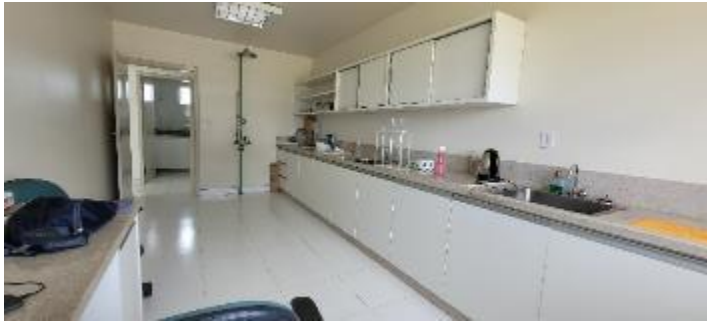
Figura 158: ETE Forquilha – Laboratório - bancada de testes.
