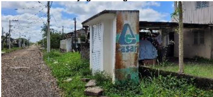
Figura 101: EEE14 Bairro Santa Ana – Rua Gabriel Eyng – visão geral.
