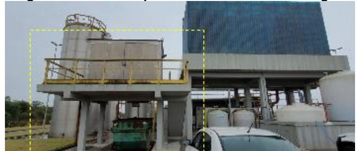
Figura 147: ETE Forquilha – Decanter centrífugo.
