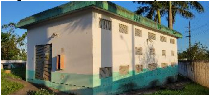
Figura 50: ETA São Defende - Subestação elétrica.
