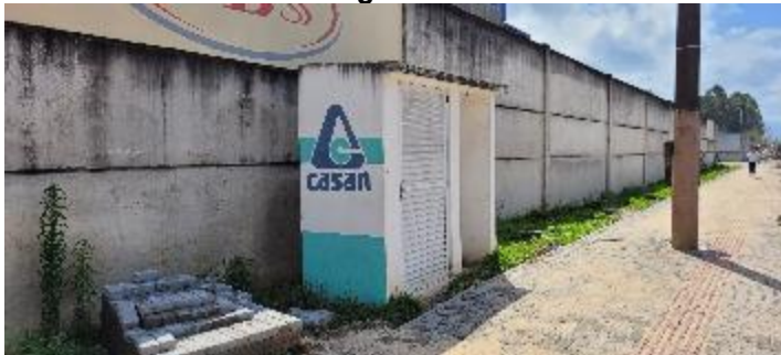
Figura 112: EEE10 – B Centro – Av. 25 de Julho – visão geral.
