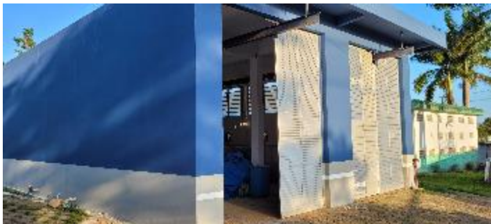
Figura 34: ETA São Defende - Casa de dosagem de cloro.
