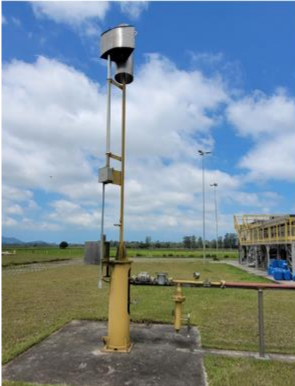
Figura 145: ETE Forquilha – Queimador de gás.
