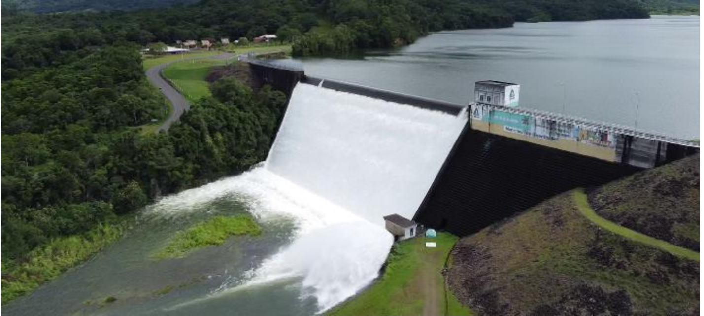
Figura 6: Barragem do Rio São Bento - Barramento Principal.
