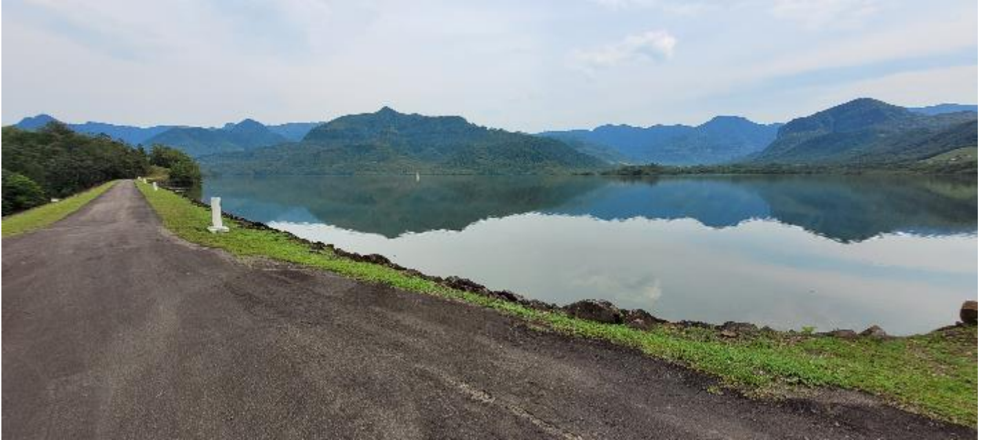
Figura 8: Barragem do Rio São Bento - Dique Principal.
