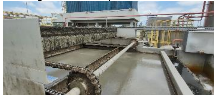
Figura 132: ETE Forquilha – Flotador.
