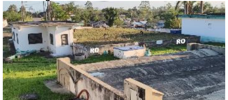
Figura 60: Reservatório R0 - 2.000 m³.
