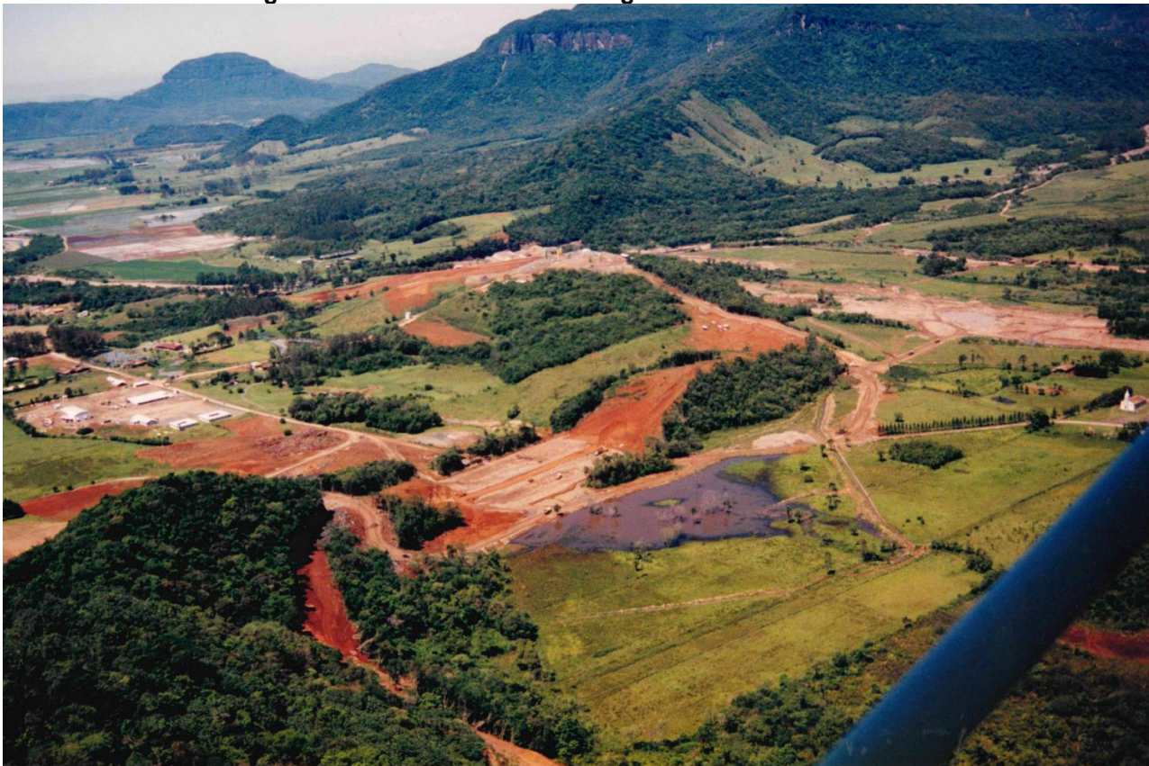
Figura 3: Vista Geral BRSB - estágio inicial das estruturas.
