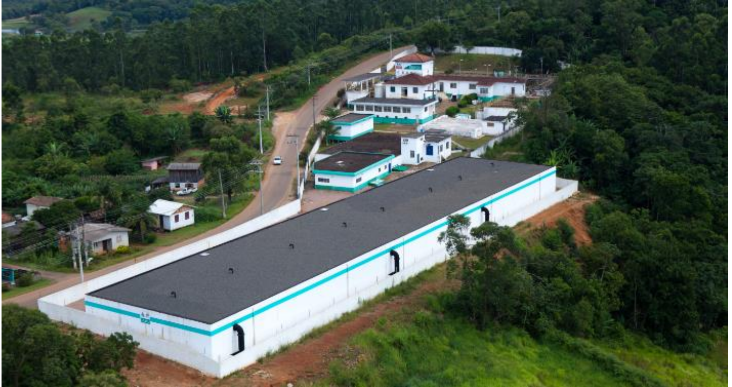
Figura 12: ETA São Defende - Vista Geral.
