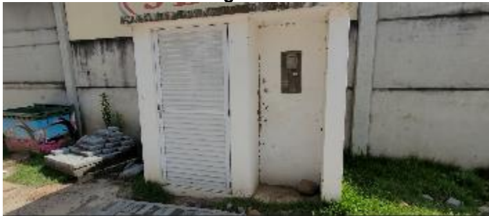
Figura 114: EEE10 – B Centro – Av. 25 de Julho – visão geral.
