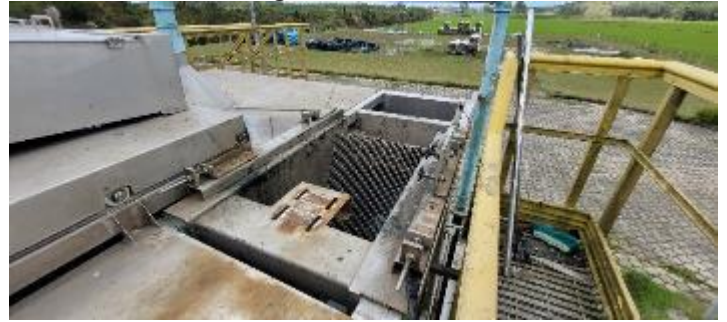
Figura 128: ETE Forquilha - Tratamento preliminar – gradeamento.
