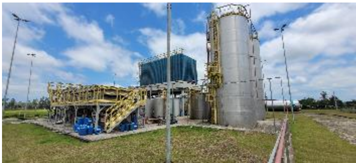
Figura 137: ETE Forquilha – Vista posterior.
